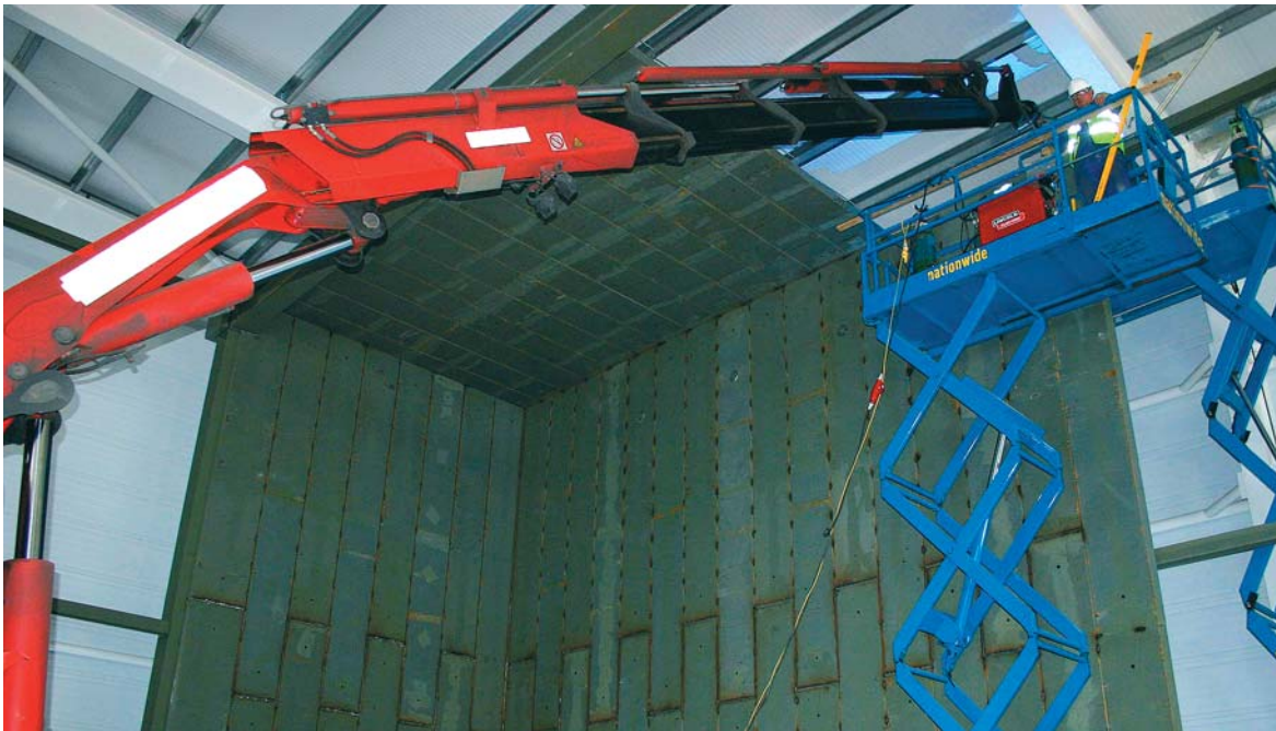
Einbau der Wandmodule CEN VIII
