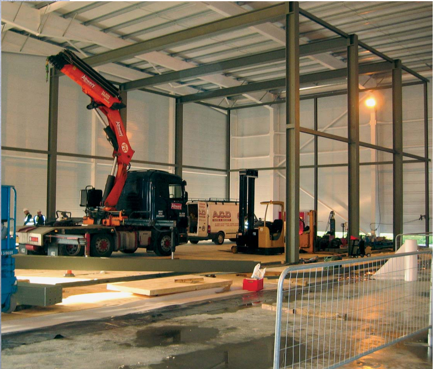
Das Stahlskelett im Aufbau
